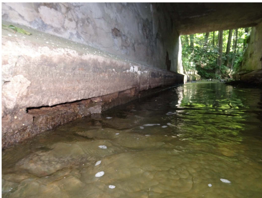
Obr. 12: Op1. Ochranný práh v patě opěry z kamen. kvádrů překrytých betonovou mazaninou. Ve výšce kolísání hladiny dochází k erozi mazaniny a vymývání vodorovného spárování kamen. kvádrů, což způsobuje jejich podemílání.
