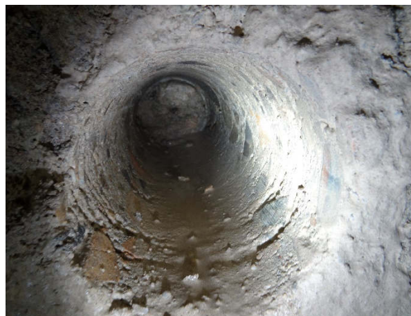
Obr. 27: Vnitřek otvoru po odbranění vzorku V4v detailním pohledu.
