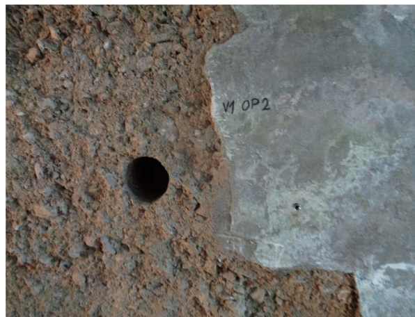
Obr. 15: Otvor po odběru vzorku V1.
