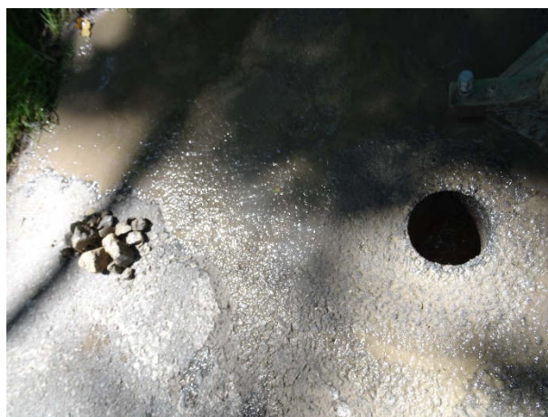
Obr. 33: Otvor po odběru vzorku V5..Na obr. vlevo – kamenivo z nezpevněné vrstvy konstrukce vozovky ze dna vyvrtaného otvoru..
