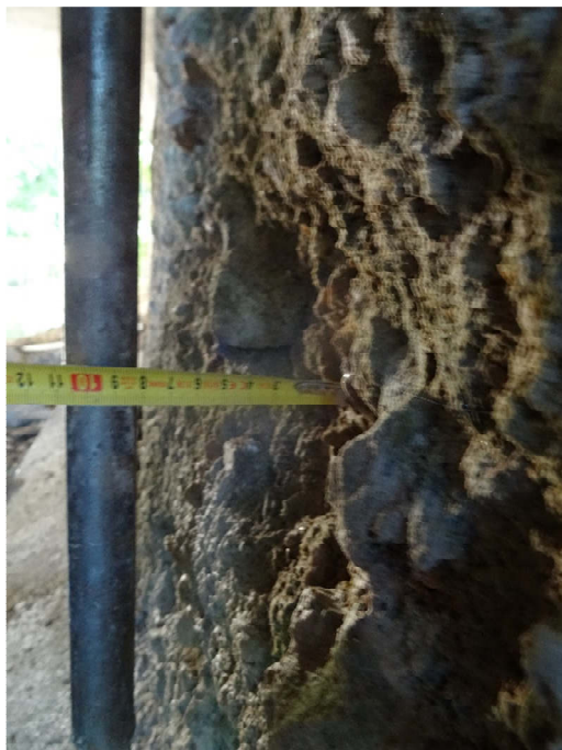
Obr. 11: Op2. Hloubka odpadlého degradovaného betonu.
