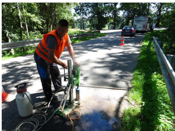
Obr. 32: Provádění vývrtnu V5 v komunikaci před mostem.
